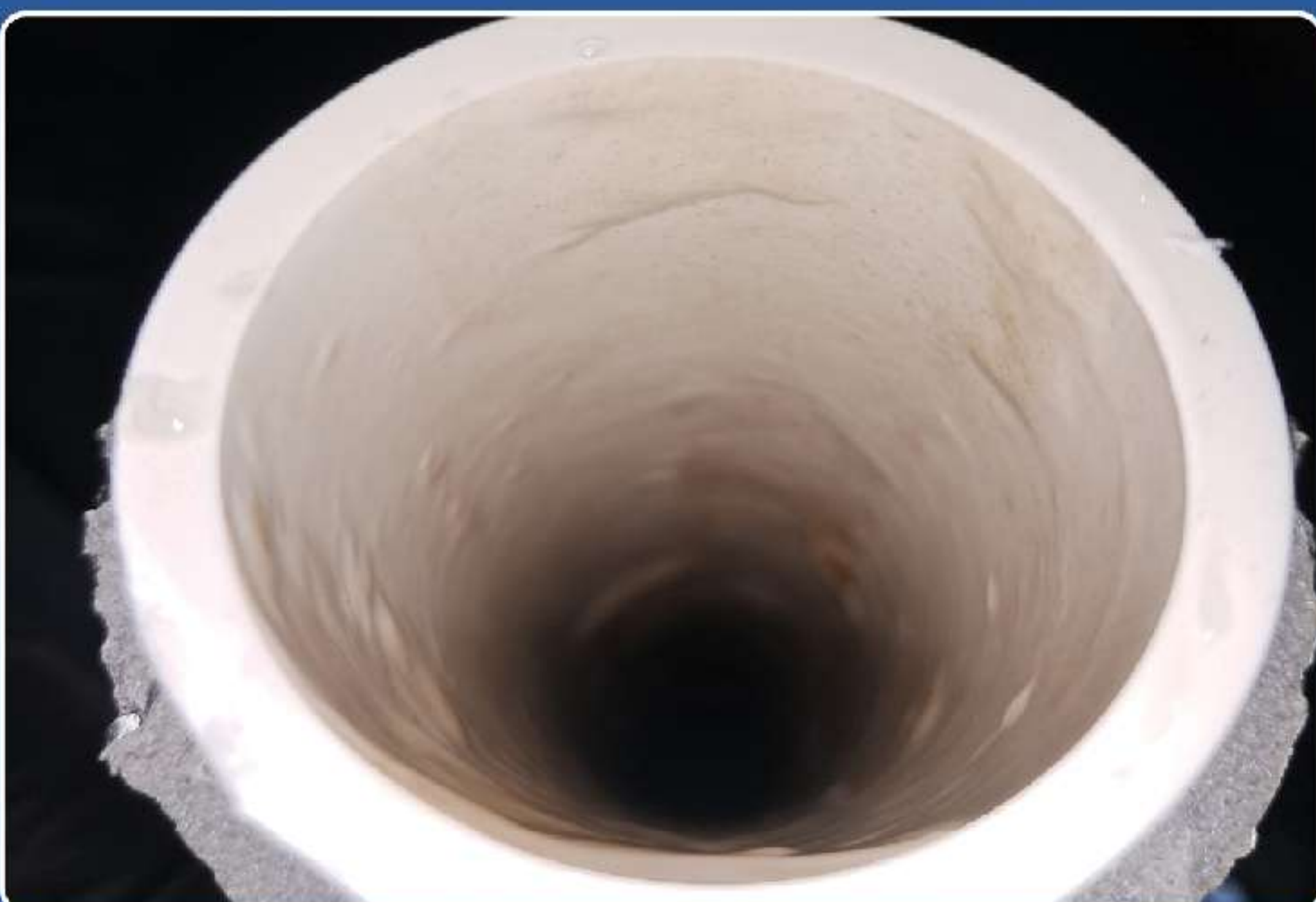
드레인관 내부 세척 후
